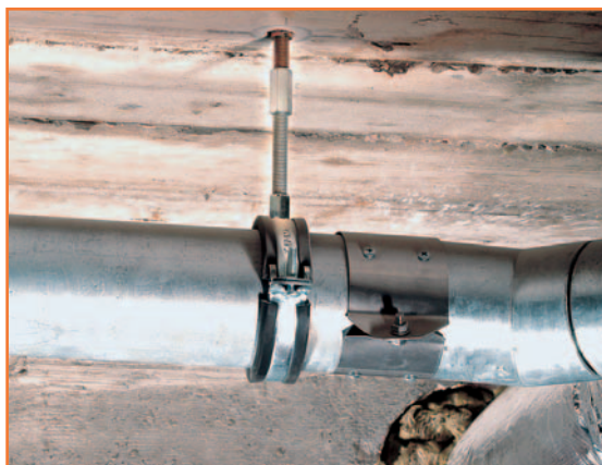
Монтаж тяжелых инженерных систем
