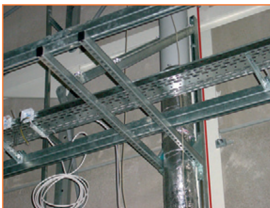
Монтаж инженерных систем
