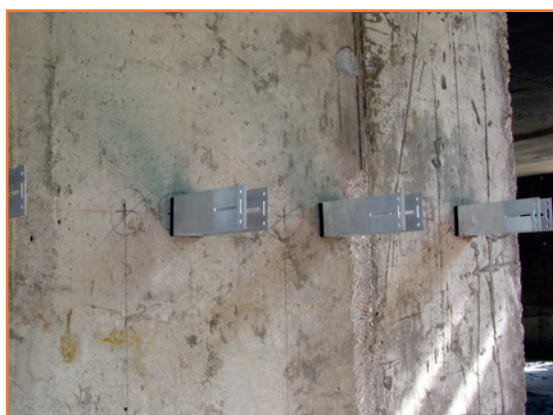
Монтаж кронштейнов НВФ
