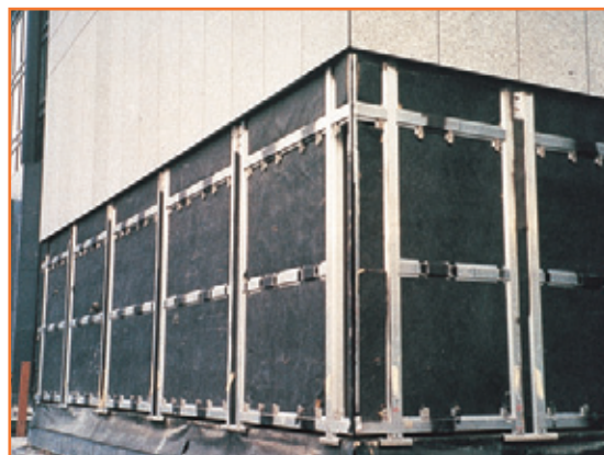
Монтаж кронштейнов НВФ
