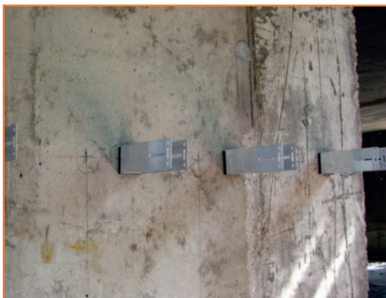
Монтаж кронштейнов НВФ
