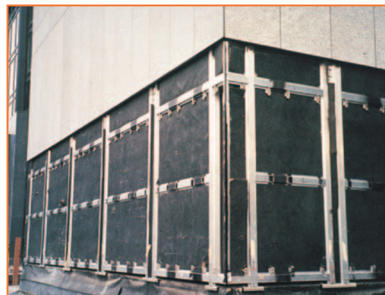
Монтаж кронштейнов НВФ
