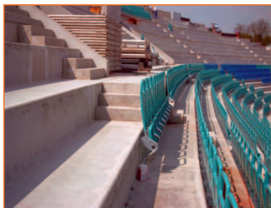
Монтаж кресел стадионов
