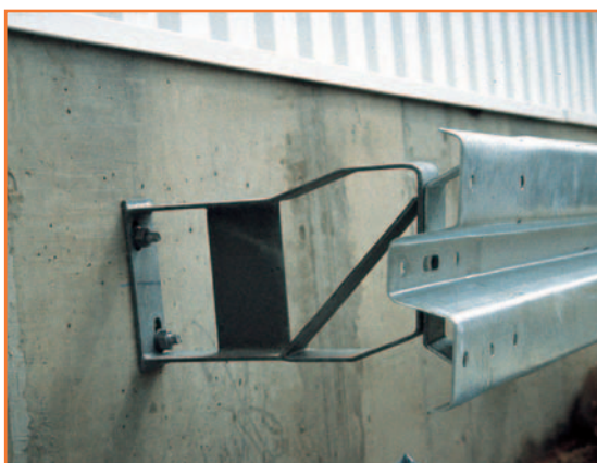
Монтаж дорожных ограждений
