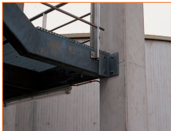
Монтаж лестничных маршей
