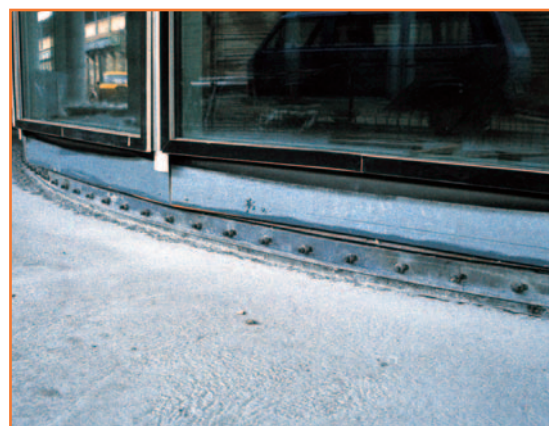
Монтаж светопрозрачных конструкций
