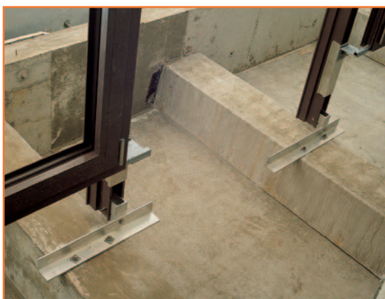
Монтаж витражных конструкций
